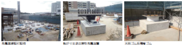
図1 免震構造設置
