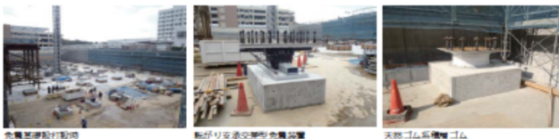
図1 免震構造設置
