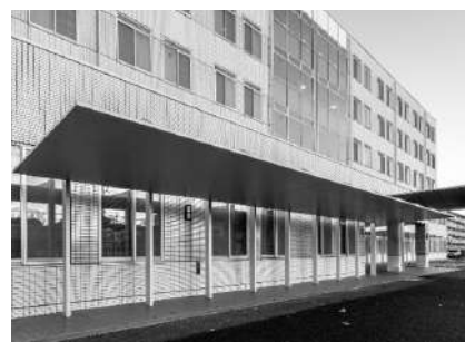
車寄せスペースへの屋根設置
