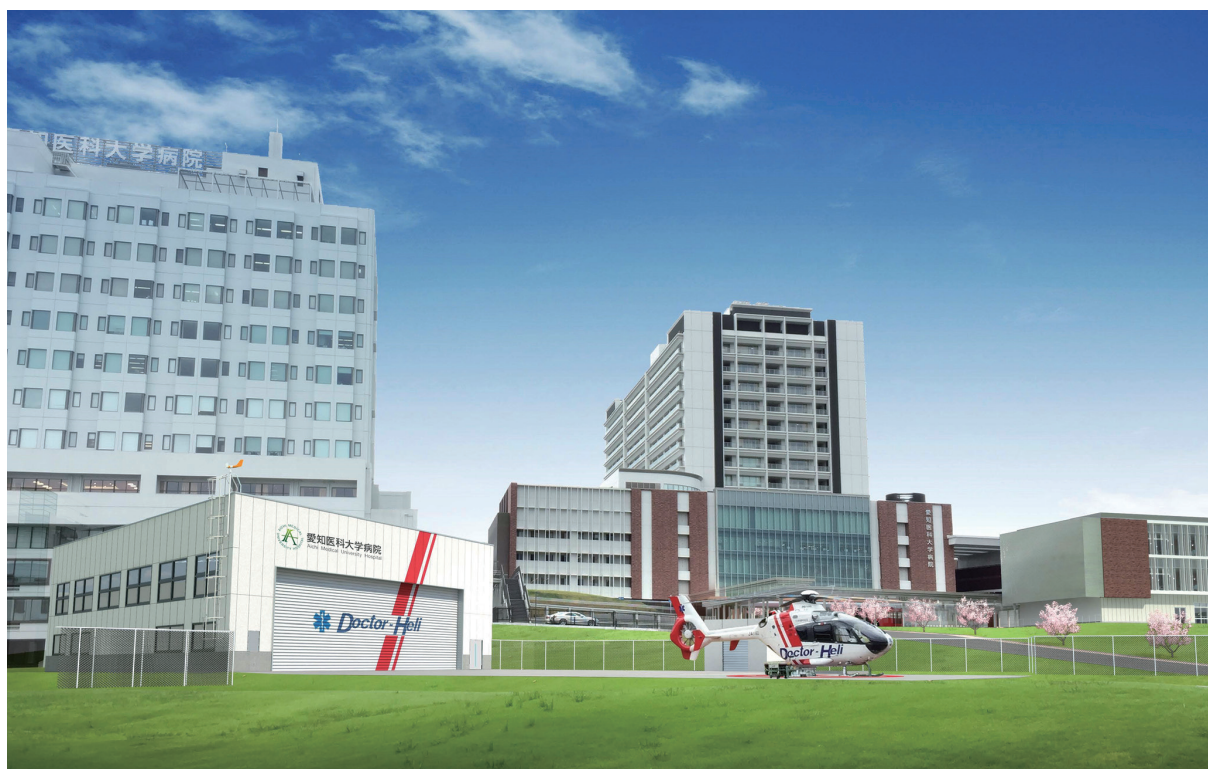
建設工事が進むドクターヘリ格納庫
