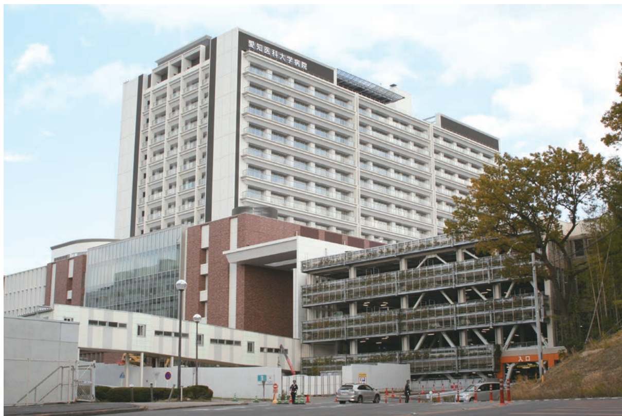
竣工間近の新病院（平成25年10月現在）
