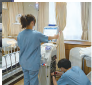
血液浄化装置の点検の様子
