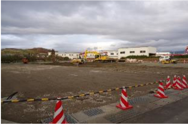
(グループホーム跡地：駐車場建設中)
