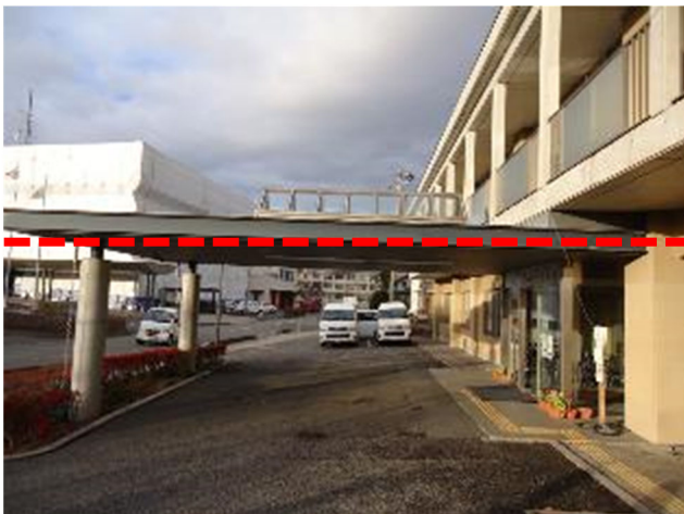
(台風 19 号による浸水) (建物 2 階まで浸水：赤線)
