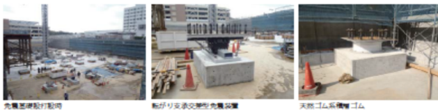
図1 免震構造設置
