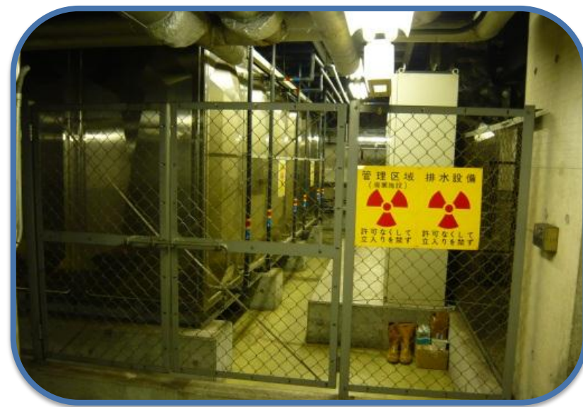
核医学実験部門施設・設備の改修（31,732千円）
