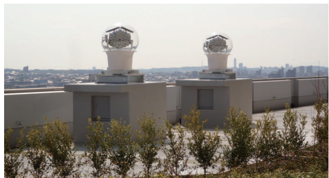
屋上庭園に設置
