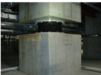
鉛プラグ入り積層ゴム (40基) 積層ゴムの変形にともなって、鉛プラグが変形。地震エネルギーを吸収し、振動を速やかに減衰します。
