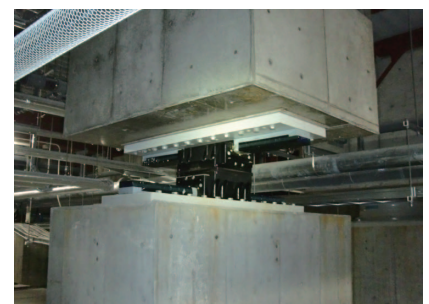
直動転がり支承 (11基) 摩擦抵抗が極めて小さく、且つ、引拔力を基礎部に伝達できる性能を持っています。
