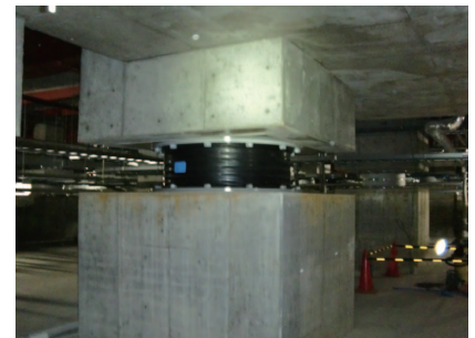
天然ゴム系積層ゴム (63基) 地震時には水平方向に柔らかく変形させ、地震力の建物への伝達を軽減します。
