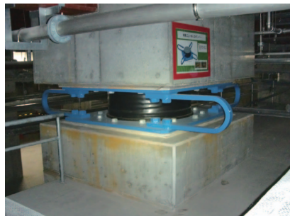
積層ゴム一体型鋼材ダンパー (31基) 地震時に鋼材の持つ復元力特性によって、地震エネルギーを吸収し、地震の揺れを低減します。
