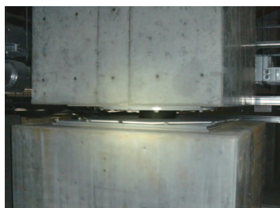
弾性すべり支承 (13基) 積層ゴムの変形と摺動材による滑りにより、小さな揺れから大地震まで、幅広く効果を発揮します。
